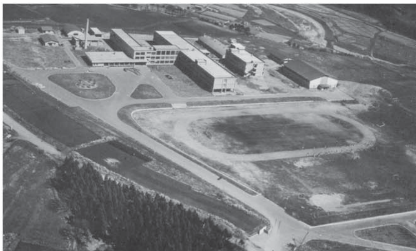
昭和 42 年 8 月 函館工業高等専門学校 校舎全景
